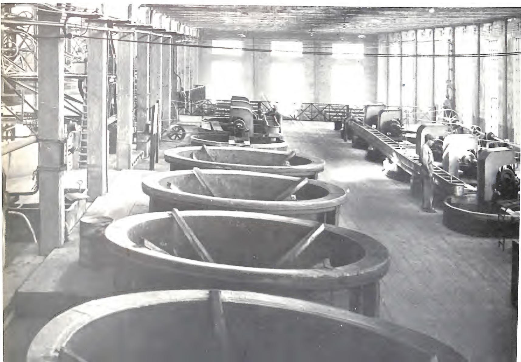
Monteponi - Impianto per lo zinco elettrolitico - Tino di depurazione.
